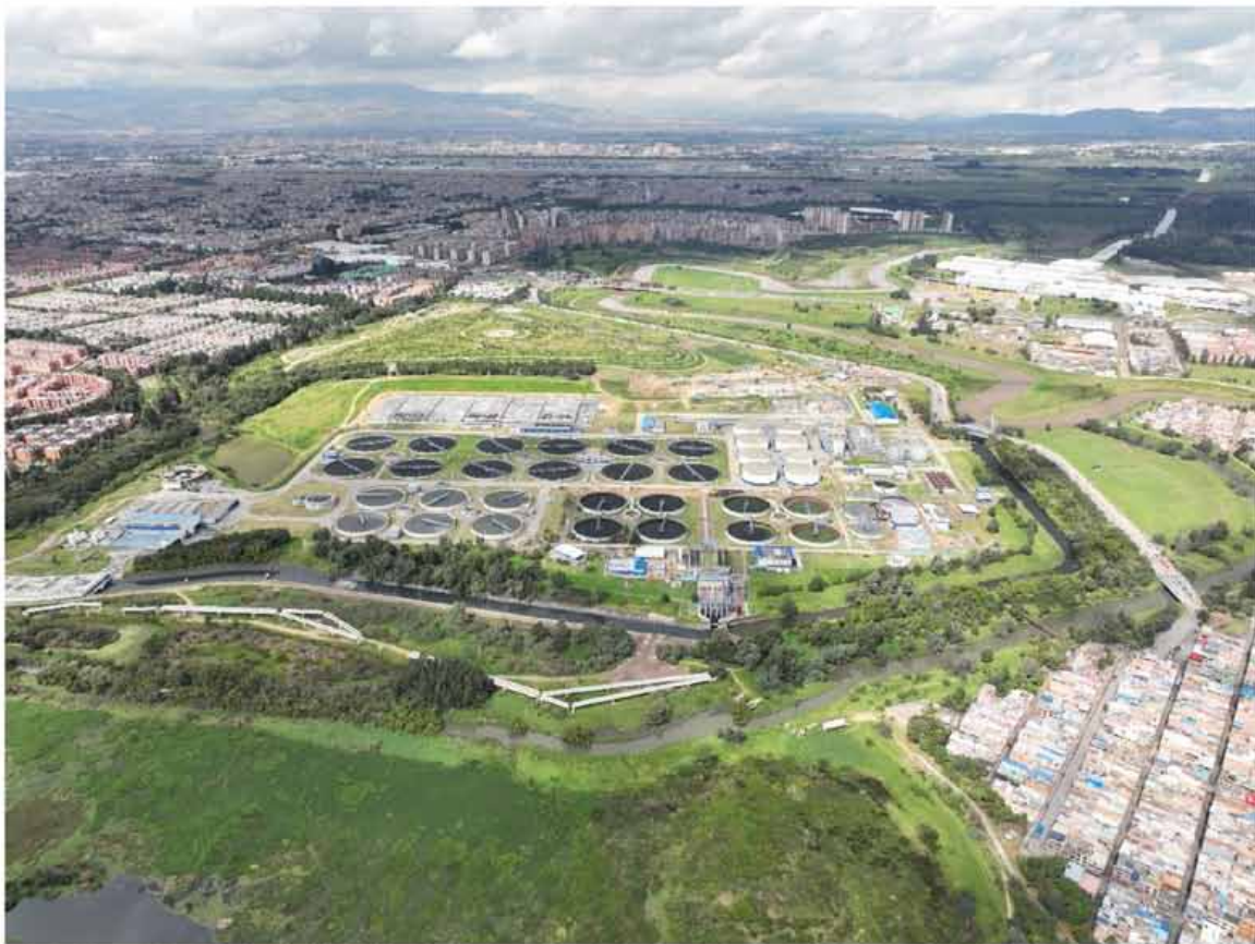
El Salitre WWTP, Colombia
