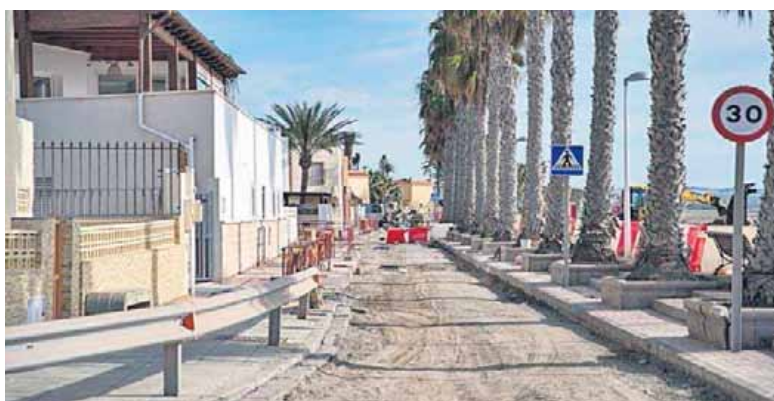
La avenida Marinera de Costacabana, en obras.
