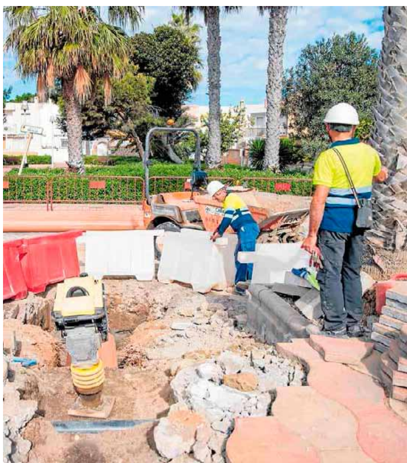
Operarios, en los trabajos que se están desarrollando junto al paseo marítimo de Costacabana. R. I.
