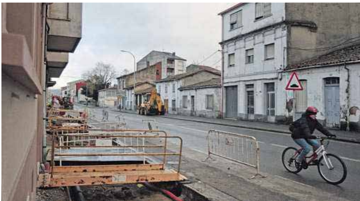
Zanjas para la sustitución de la vieja tubería en el Morín, en una imagen de archivo. CARLOS CORTÉS
