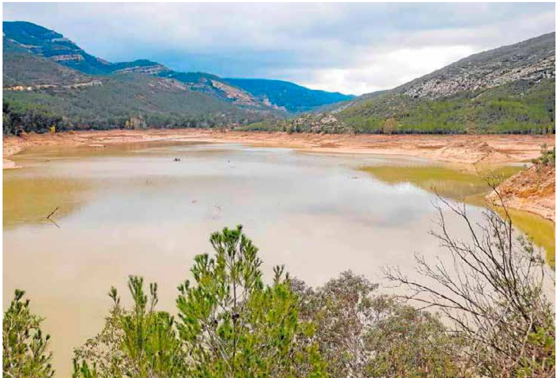
Obras de reconstrucción de la presa de Buseo después de las grietas sufridas como consecuencia de la dana. IRENE MARSILLA
