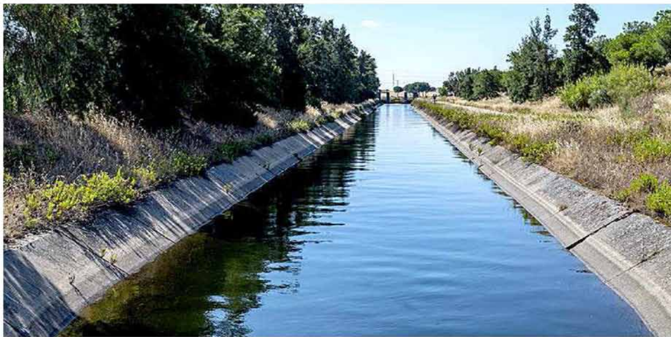
El 70% de las obras hidráulicas de interés general para el regadío están todavía por ejecutar.
