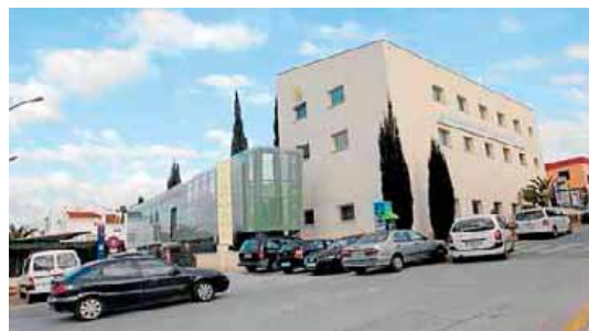
Imagen del edificio donde se encuentra Acosol en Marbella. JOSELE
