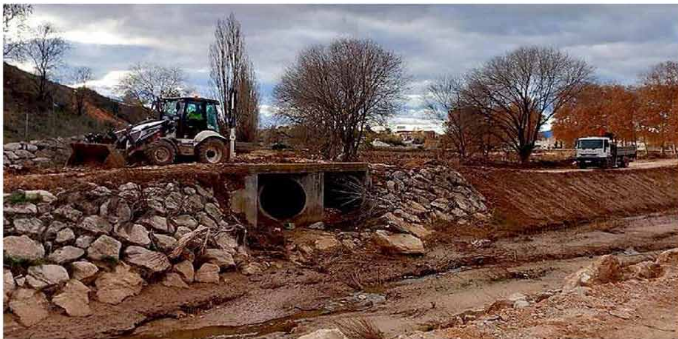
Trabajos de retirada de arbolado en el cauce del río Buñol, a su paso por Alborache
