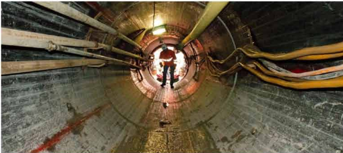
Uno de los métodos permite crear una pared nueva interna en los viejos colectores.
